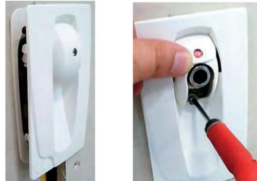
ⓘ La façade peut être démontée par la suite pour boucher la saignée et finaliser les travaux de peinture.
