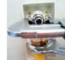
Mettre en place et fixer la vanne dans le boîtier.
