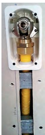
⚠ Protéger la vanne lorsque la façade est démontée.
